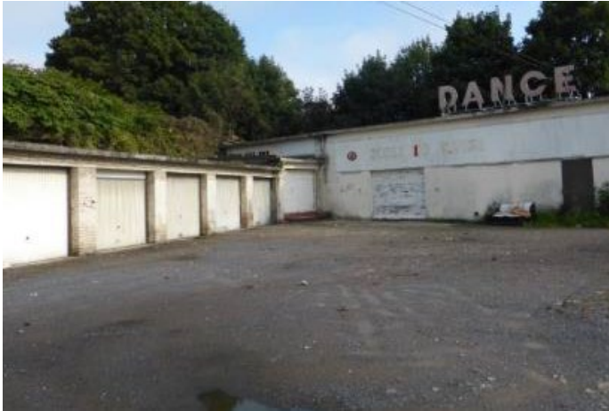
Vue sur les garages de l'îlot Lafleur Defaux
